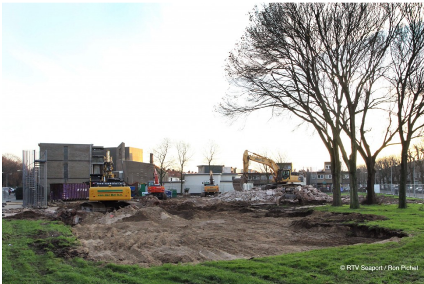
Sloop van het Willem de Zwijger gebouw najaar 2015
